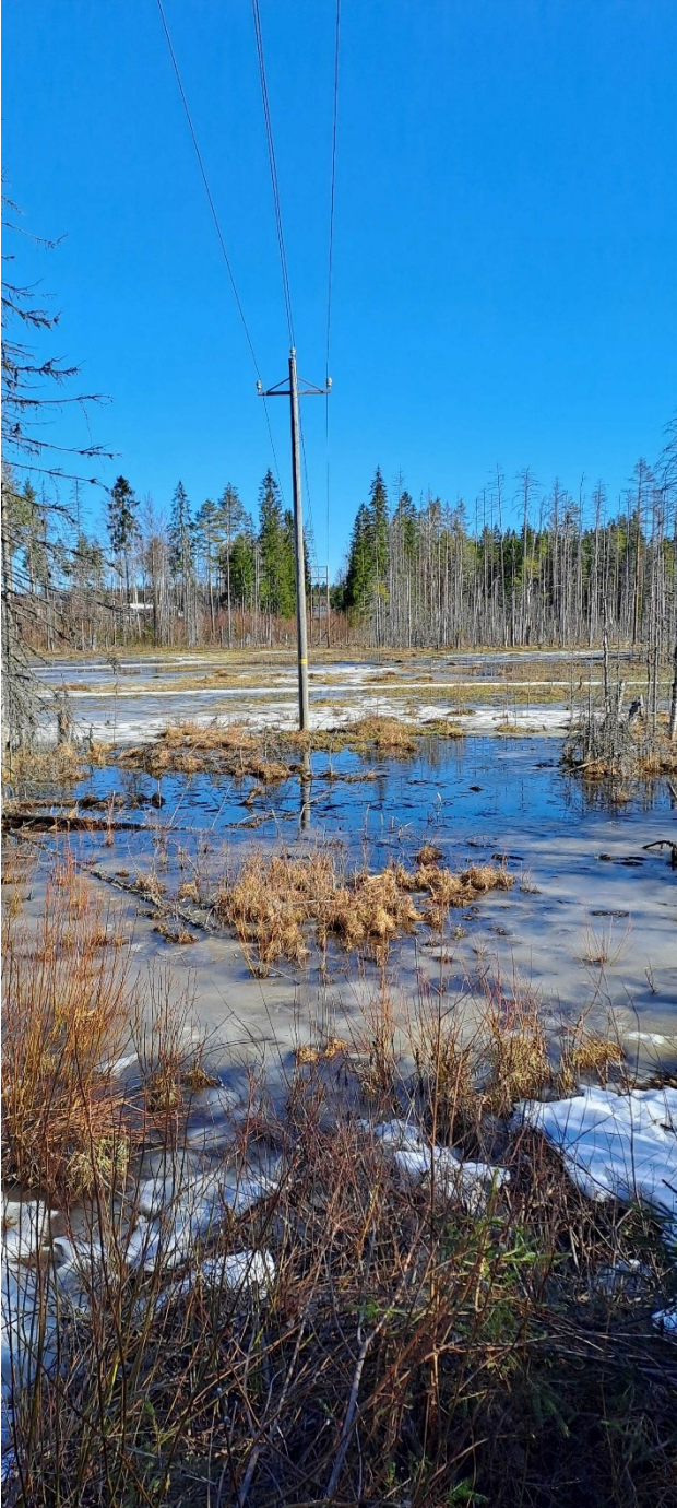
Kuva 8. Sähkölinja kuvattuna keväällä 2024 etelästä meluvallin kohdalta.
